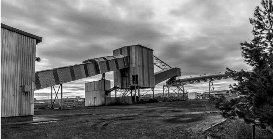
Vista de la zona de carbones. Foto: Carlos Colás
